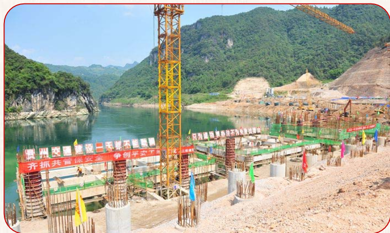
构皮滩翻坝工程
